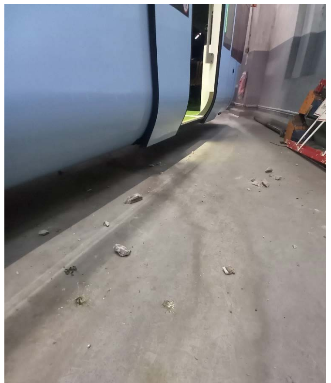
Bild 64 und 65: Abplatzung im Bereich eines FW-Binders und Bruchstücke, Fotos vom 26.03.2025)
