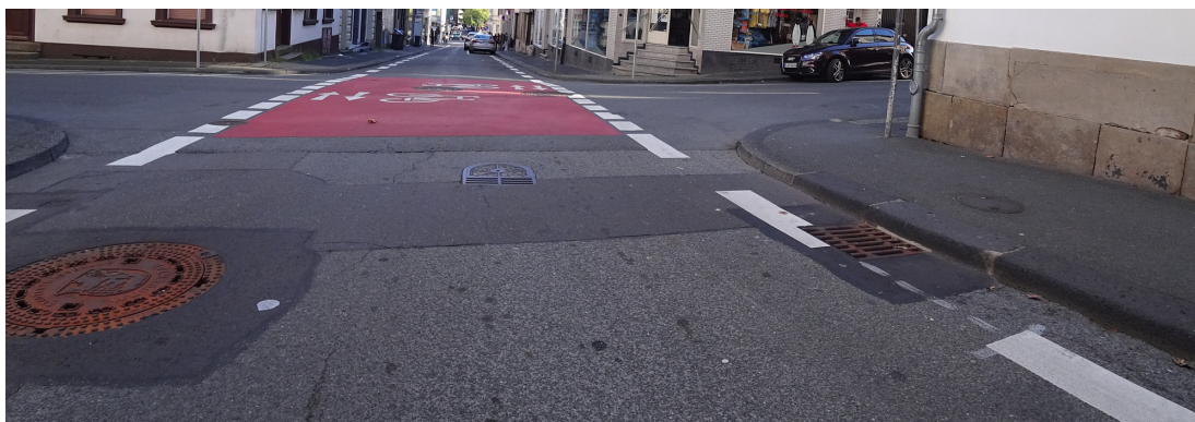
Abb. 3: Die Querschnittselemente in der Praxis, hier: Friedrichstraße. Die weißen Leitlinien sollen die Fahrbahn schmaler wirken lassen und einen seitlichen Sicherheitsabstand zum Fahrbahnrand bzw. parkenden Fahrzeugen absichern.
