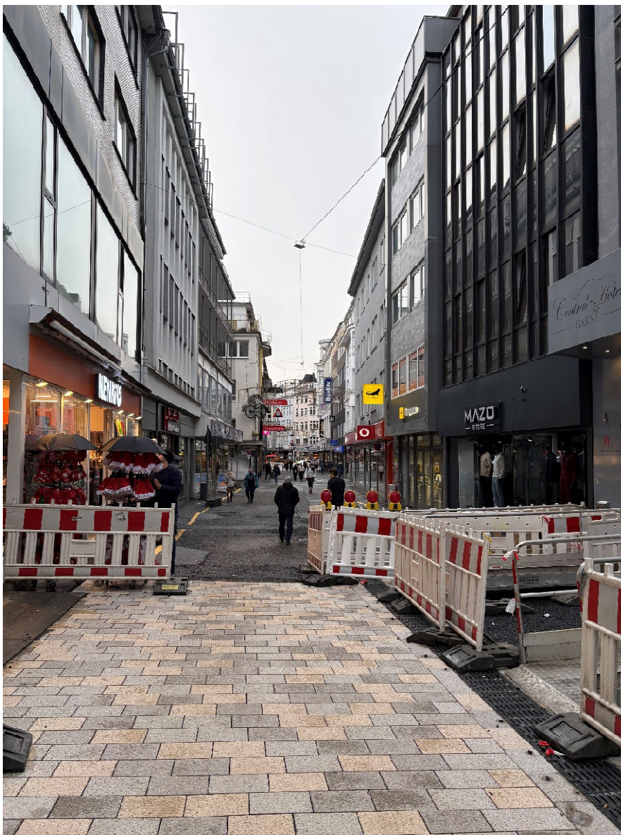
Abb. Erster gepflasterter Abschnitt Poststraße (Teilprojekt SW)
