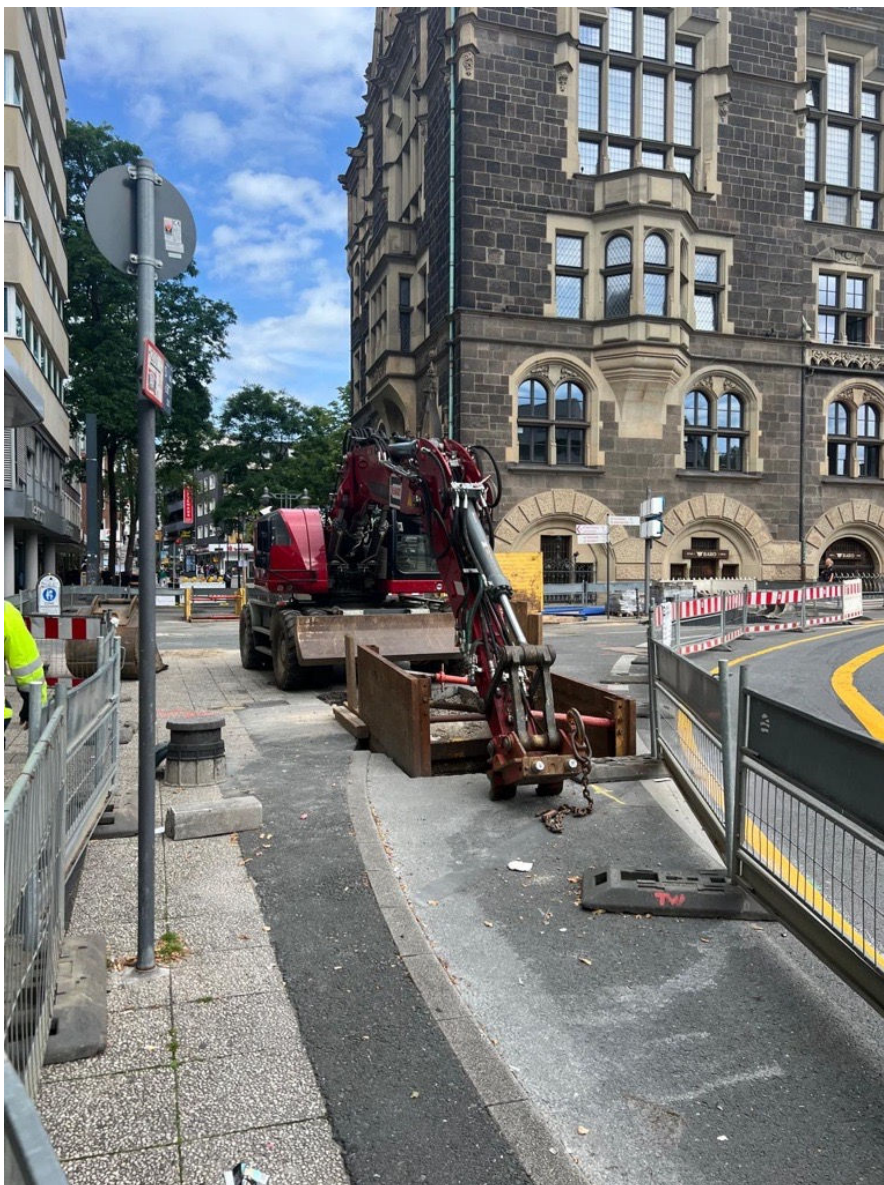
Abb. Baubeginn Neumarktstraße Ecke Wall (Kanalarbeiten WSW)
