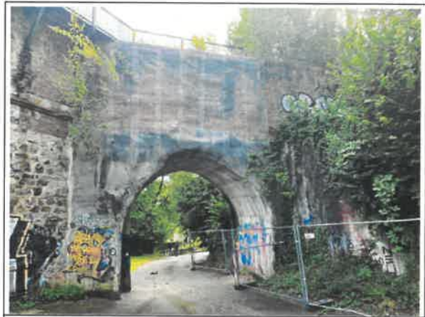
Bild 4: Ansicht der Zufahrtbrücke von Norden.
