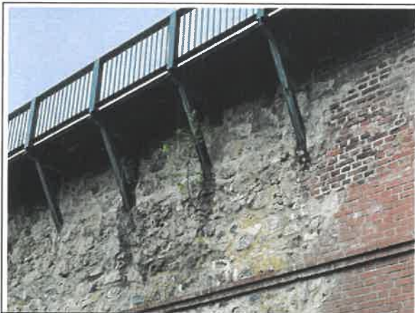
Bild 9: Beispiele für die Wasserfahnen ...
