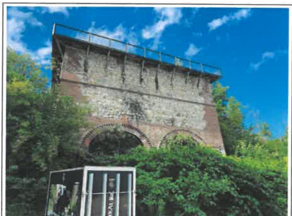
Bild 2: Ansicht des Kalktrichterofens von Süden.
