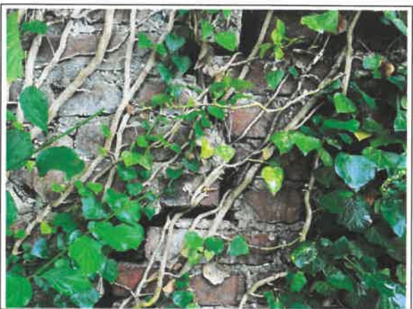
Bild 22: ... mit fingerdick offenen Fugen.
