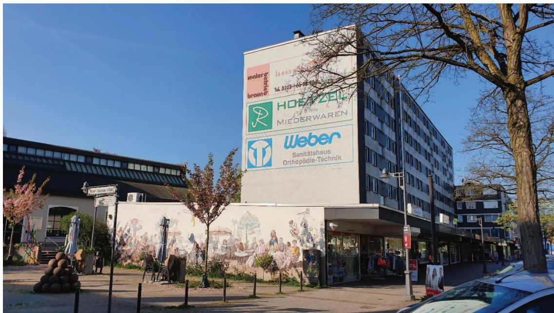
Foto: Einzelhandelsobjekt (1-geschoßig) direkt an der Berliner Straße
