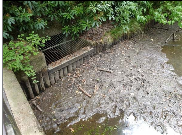
Abb. 15: Mönchbauwerk des „Achterteichs“
