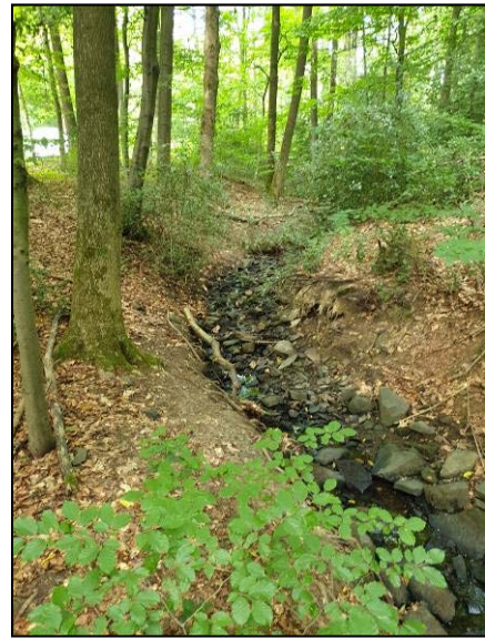
Abb. 2: Abschnitt des Vogelsangbachs mit Steinschüttung
