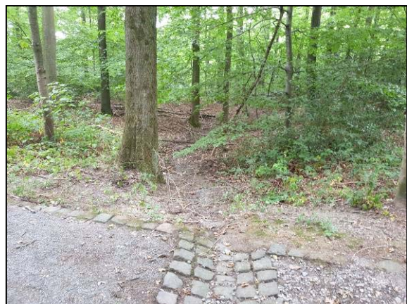
Abb. 11: Wegeüberführung eines Nebenlaufs mit Pflasterrinne
