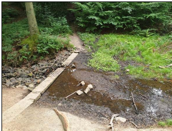
Abb. 3: Ziegelmauer als Staustufe im Bereich unterhalb des „Achtereichs“
