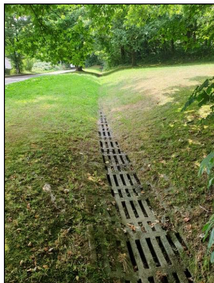
Abb. 9: Mit Betongittersteinen ausgebaute Sohle eines Nebenlaufs
