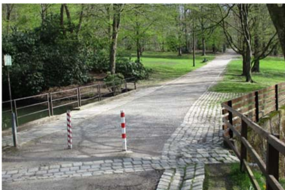
52 Ausgestaltung Geländer Bauwerk am Achterteich
