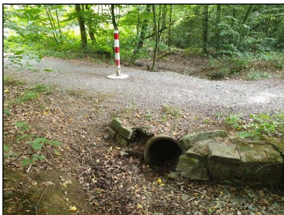
Abb. 10: Verrohrung eines Nebenlaufs begleitet von einer Steinsatzmauer
