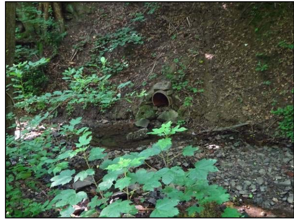
Abb. 4: Einleitung der Oberflächenentwässerung anliegender Flächen
