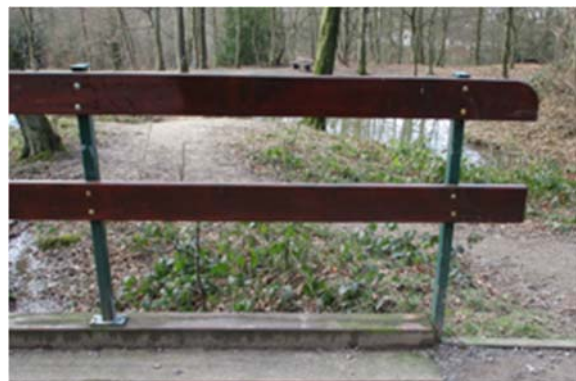
53 Absturzsicherung an Brücke
