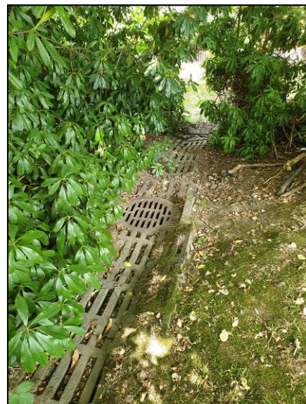
Abb. 17: Schacht in der Sohle des westlichen Zulaufs zum „Achterteich“
