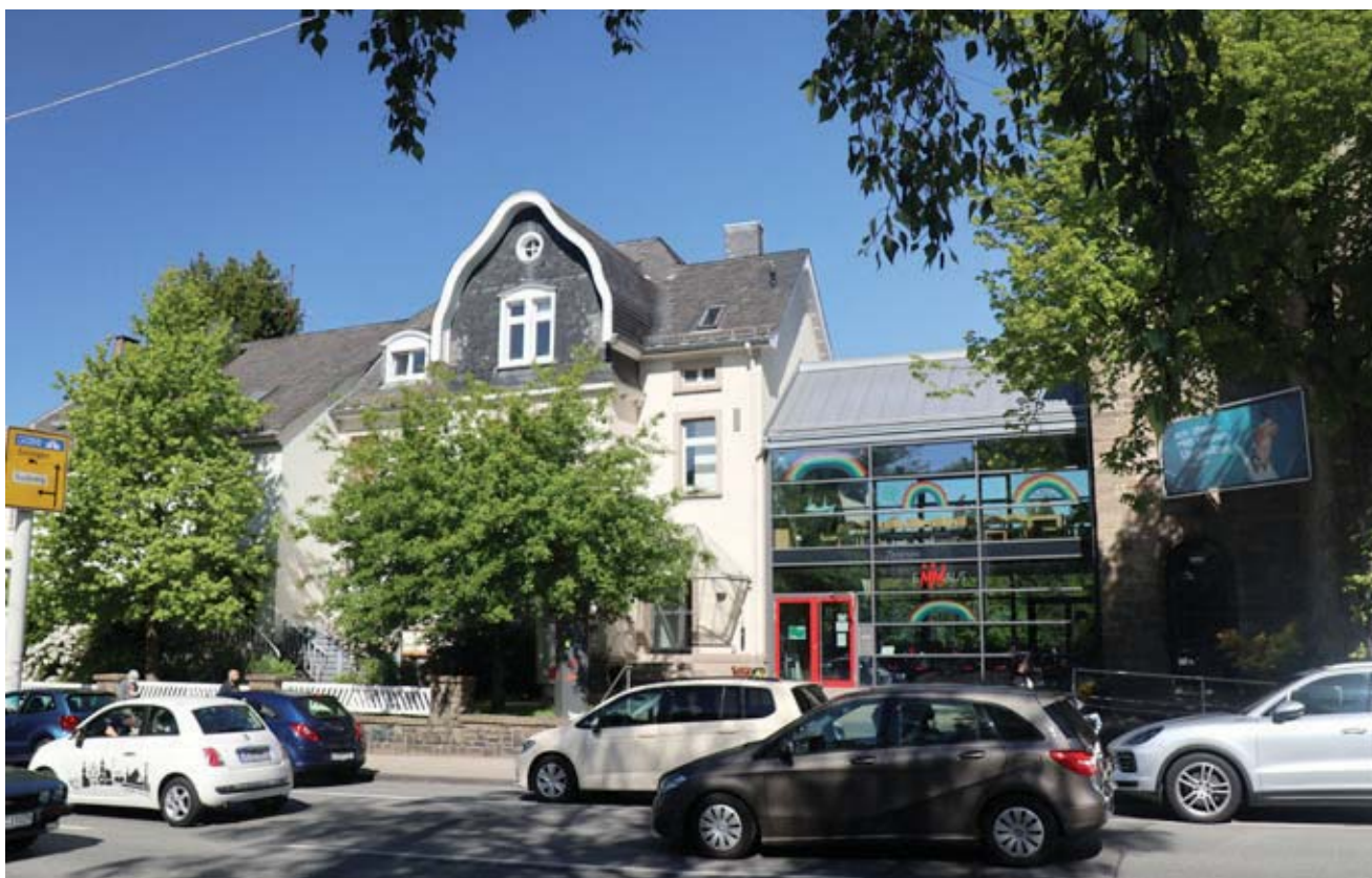
HAUPTSTRASSE 37A & 37B
