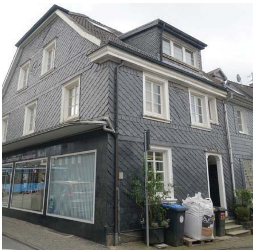
HAUPTSTRASSE 13 (RÜCKSEITE, AN DER HÜTTE)
