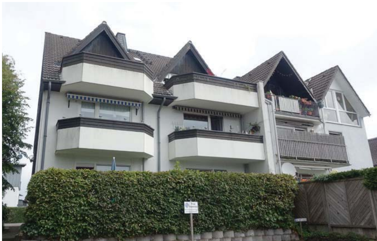
SOLINGERSTRASSE 15 & 17 (RÜCKSEITE, SCHORFERSTRASSE)
