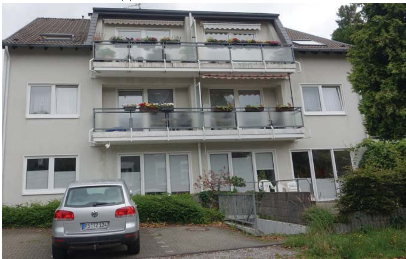
SOLINGER STRASSE 25 (RÜCKSEITE, SCHORFER STRASSE)
