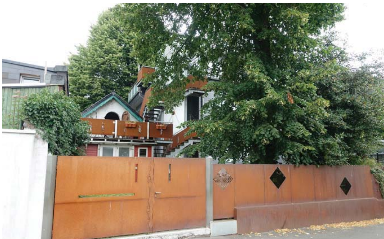
SOLINGER STRASSE 19 (RÜCKSEITE, SCHORFER STRASSE)
