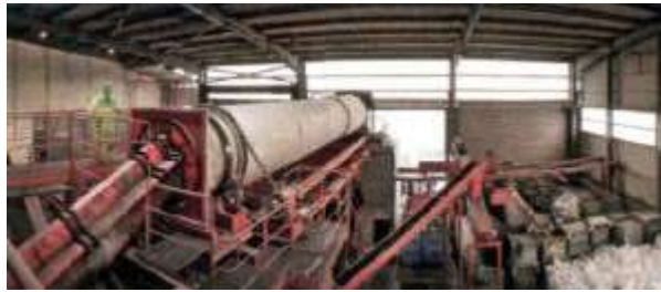
Kryogene Recyclinganlage der Firma Nehlsen 1
