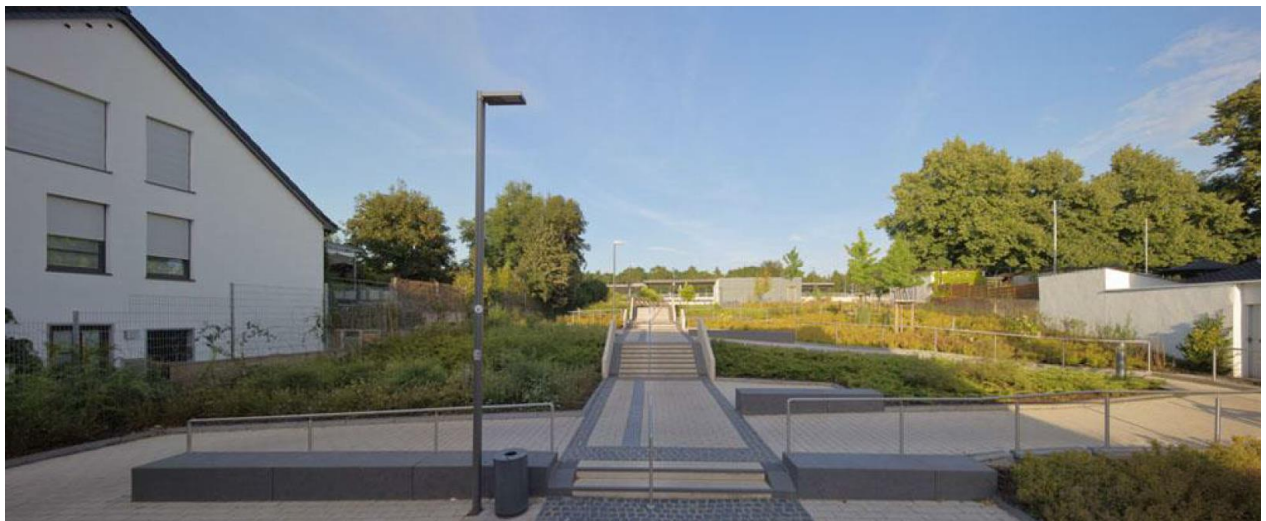
Abb. 2-7: Beispiel kombinierte Rampen- und Treppenanlage (Zuwegung Bahnhof Ertstadt)
