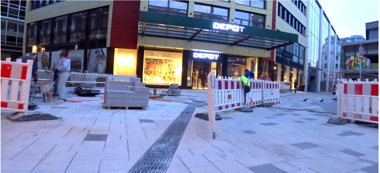
Abb. 1: Was ist Baustelle, was „Fußgängerzone“? Abgesperrt ist nach Lust und Laune, nur nicht nach Vorschrift.
