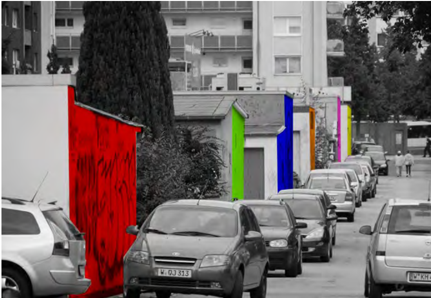
Denkbare Aufwertung der Garagenstirnwände durch farbliche Gestaltung.
