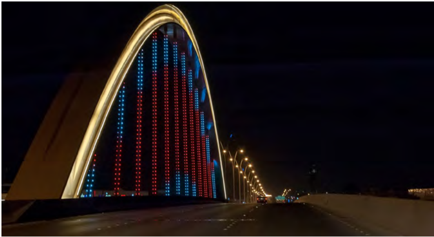
Assoziationsfoto. Brücke mit ansteuerbaren RGB-Punkten an den Stahlseilen.
