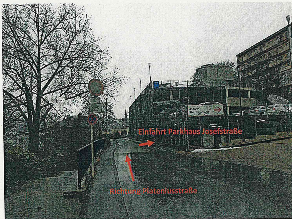
Abbildung 3: Sicht Josefstraße Richtung Plateniusstraße mit VZ 250 und ZZ 1020-30
