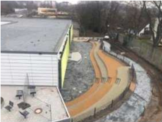
Abbildung 10: Außengelände Stadtteilzentrum Langerfeld nach Maßnahmenabschluss
