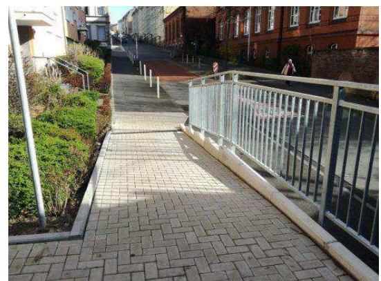
Abbildung 4: Zugang zur Nordbahntrasse nach Maßnahmenabschluss
