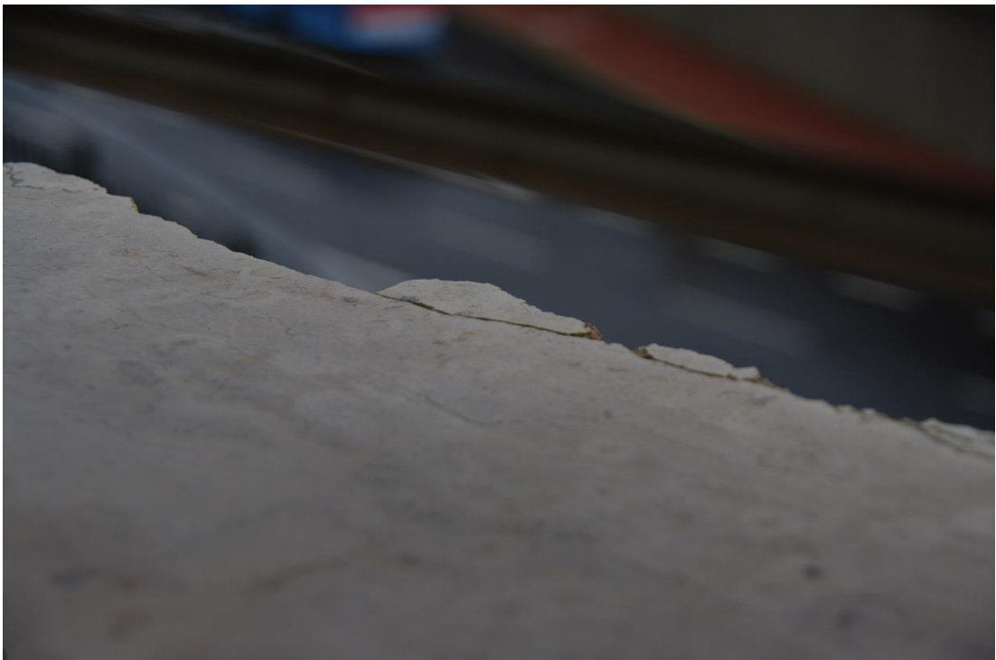
Foto 17: an der Krustenoberfläche „auskeilende“ Stylolithen; Scherbenbildung vorprogrammiert
