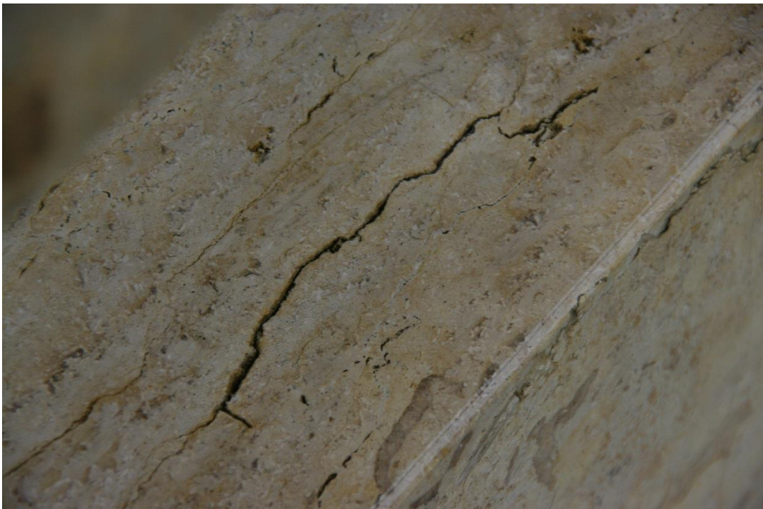
Foto 29: Beispiel für weiter hinten liegende Stylolithen, bei denen sich ggf. dickere Schichtpakete ablösen können
