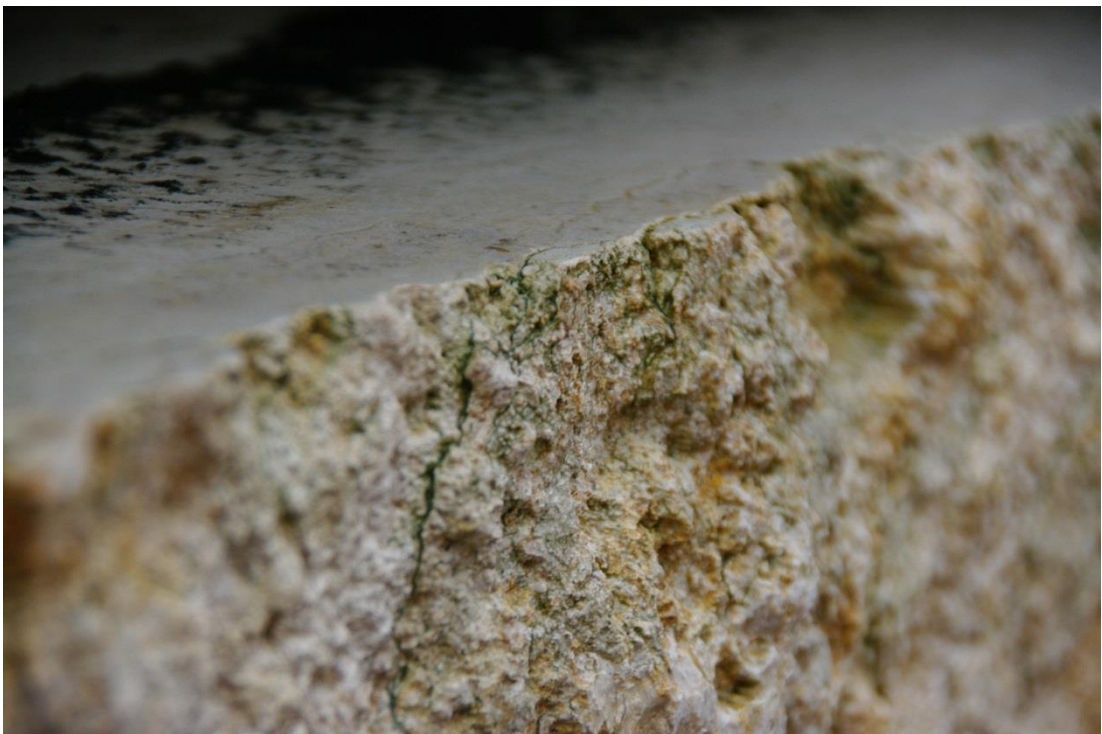
Foto 10: Ablösungserscheinungen resp. Ausbildung von Scherben an der Krustenoberfläche
