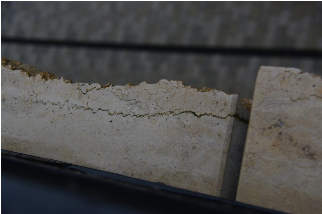
Foto 30: Beispiel für weiter hinten liegende Stylolithen, bei denen sich ggf. dickere Schichtpakete ablösen können
