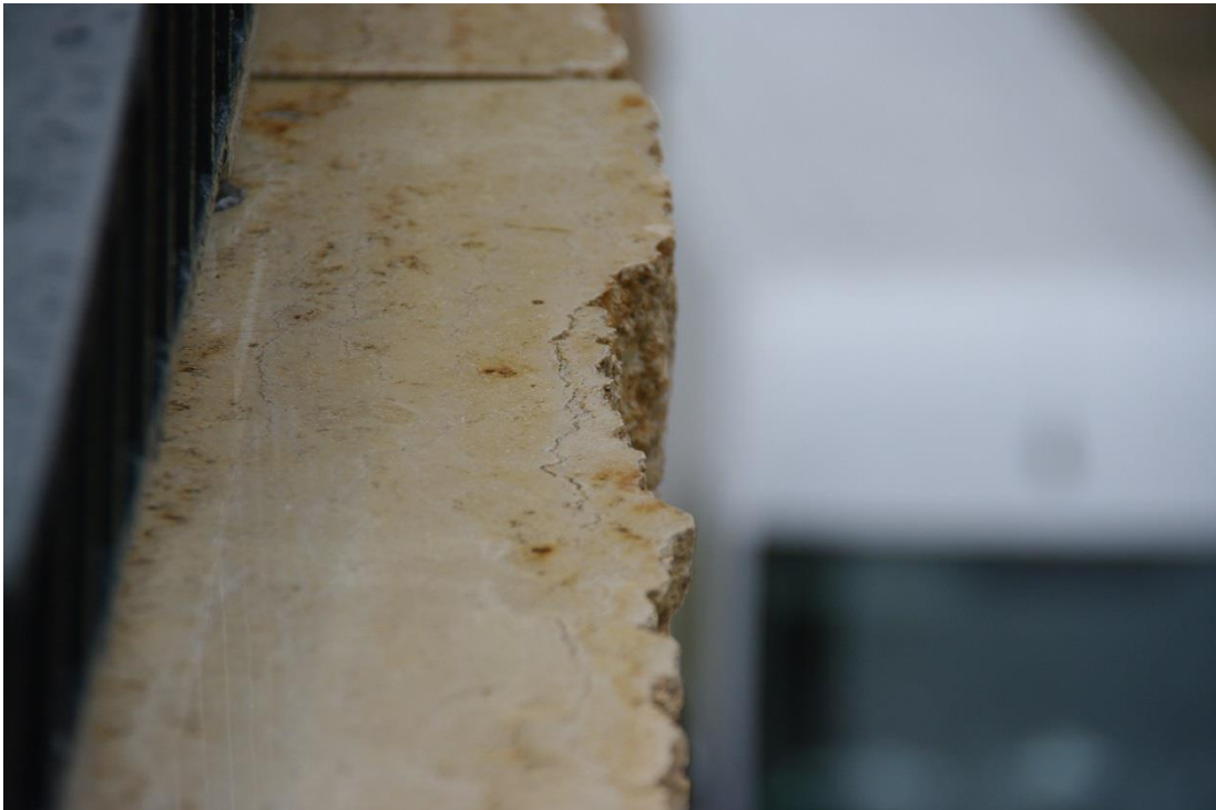
Foto 20: an der Krustenoberfläche „auskeilende“ Stylolithen
