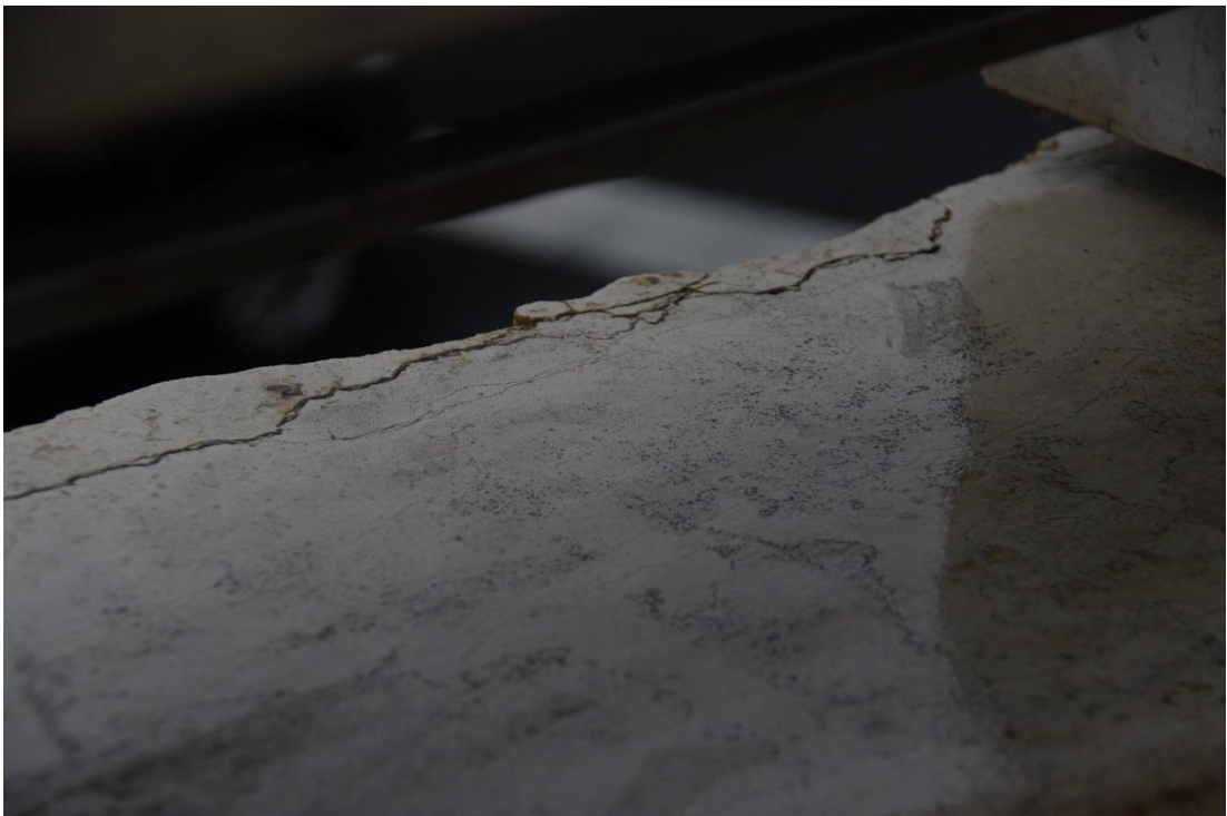
Foto 26: an der Krustenoberfläche „auskeilende“ Stylolithen; Scherbenbildung vorprogrammiert
