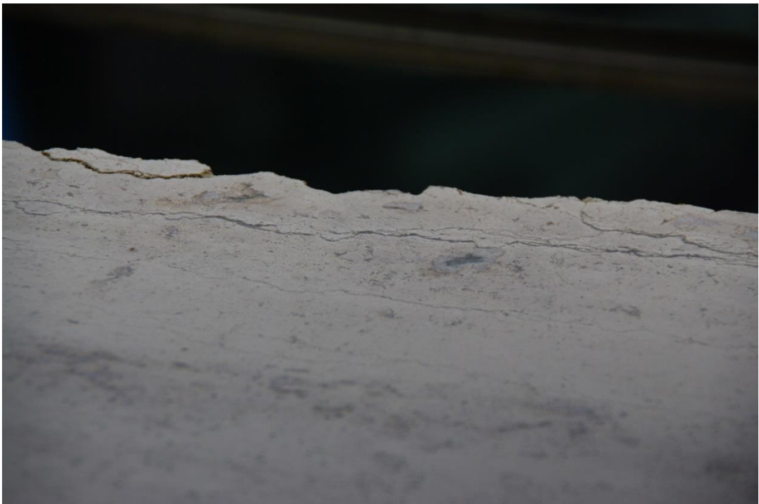
Foto 27: an der Krustenoberfläche „auskeilende“ Stylolithen; Scherbenbildung vorprogrammiert
