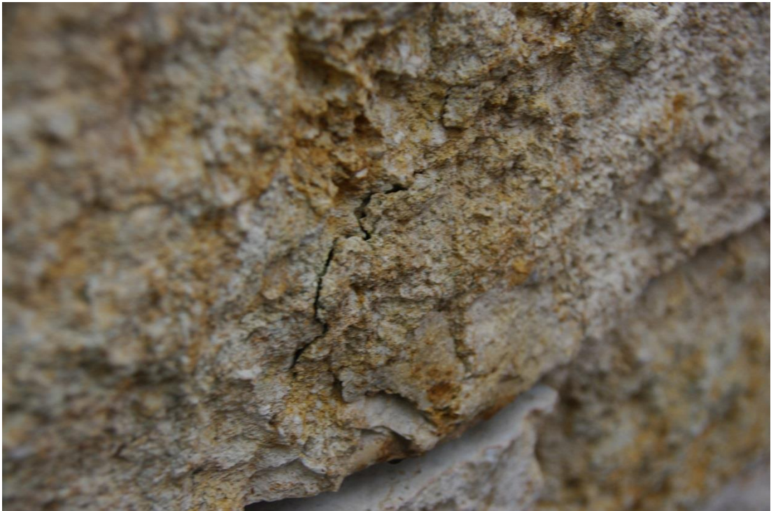
Foto 9: Ablösungserscheinungen resp. Ausbildung von Scherben an der Krustenoberfläche
