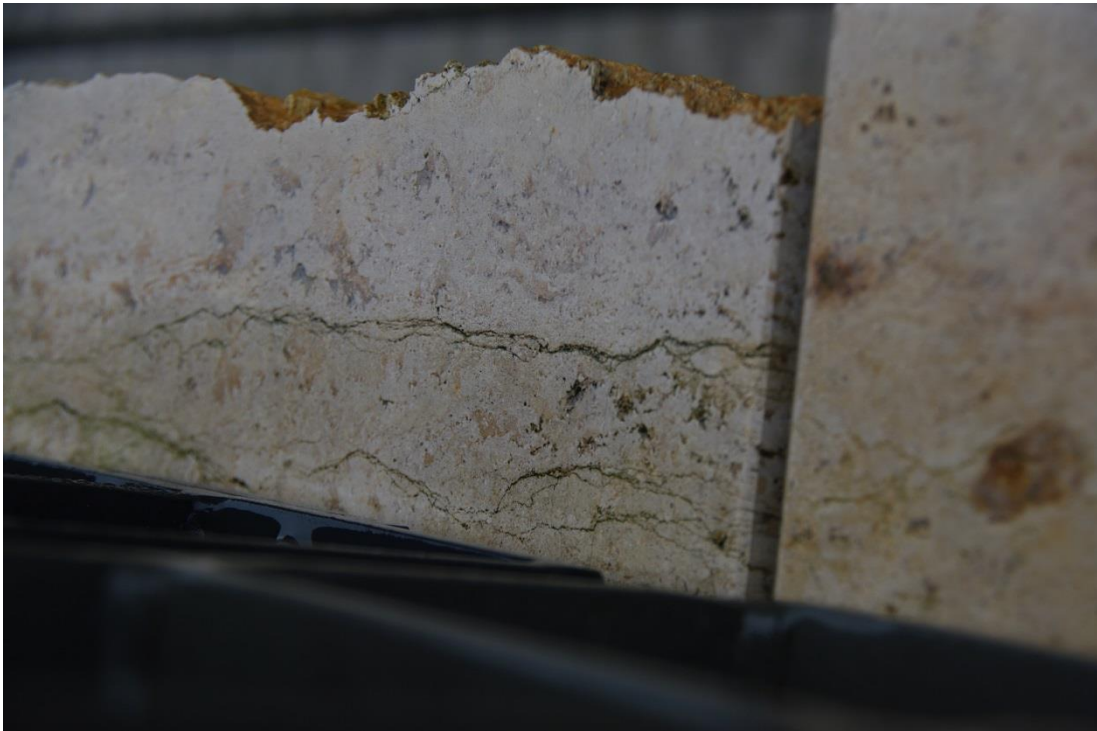
Foto 32: Beispiel für weiter hinten liegende Stylolithen, bei denen sich ggf. dickere Schichtpakete ablösen können
