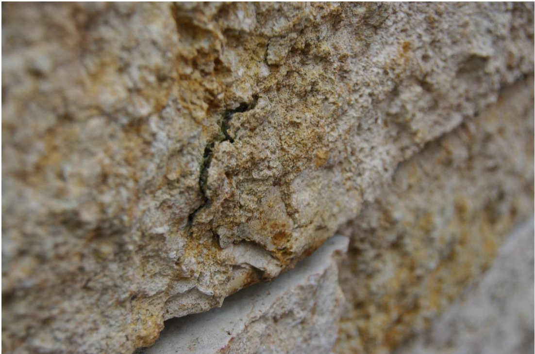
Foto 11: Ablösungserscheinungen resp. Ausbildung von Scherben an der Krustenoberfläche
