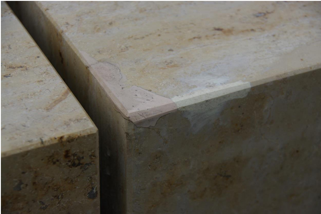
Foto 41: 2 Spachtelungen an einer anderen Ecke eines Mauersteins; Haarriss bereits an der linken Spachtelung vorhanden
