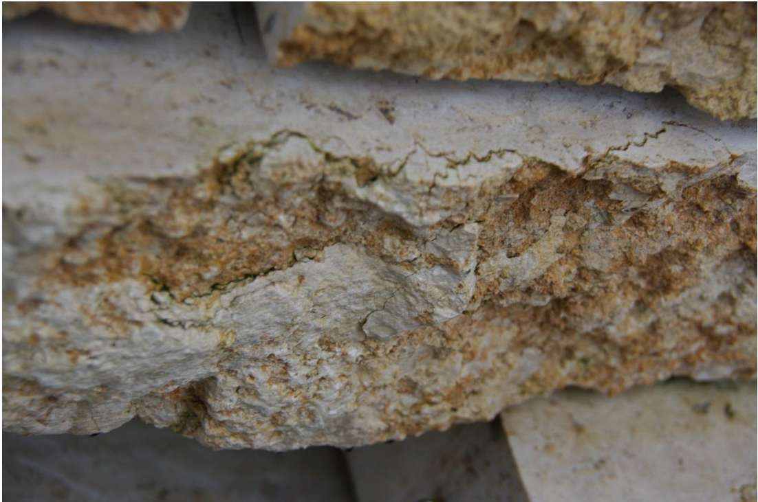
Foto 16: an der Krustenoberfläche „auskeilende“ Stylolithen
