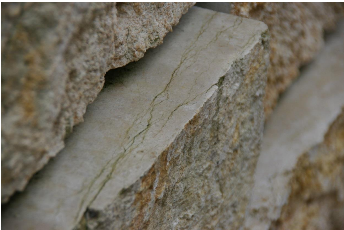
Foto 15: an der Krustenoberfläche „auskeilende“ Stylolithen
