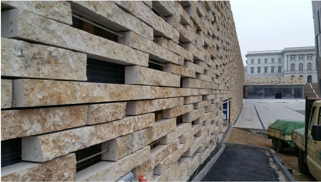
Foto 1: Blick parallel zur Front Zufahrt Parkhaus / Eingänge zur Bahnhofshalle; Foto aus der Bauphase (Quelle: Stadt Wuppertal)
