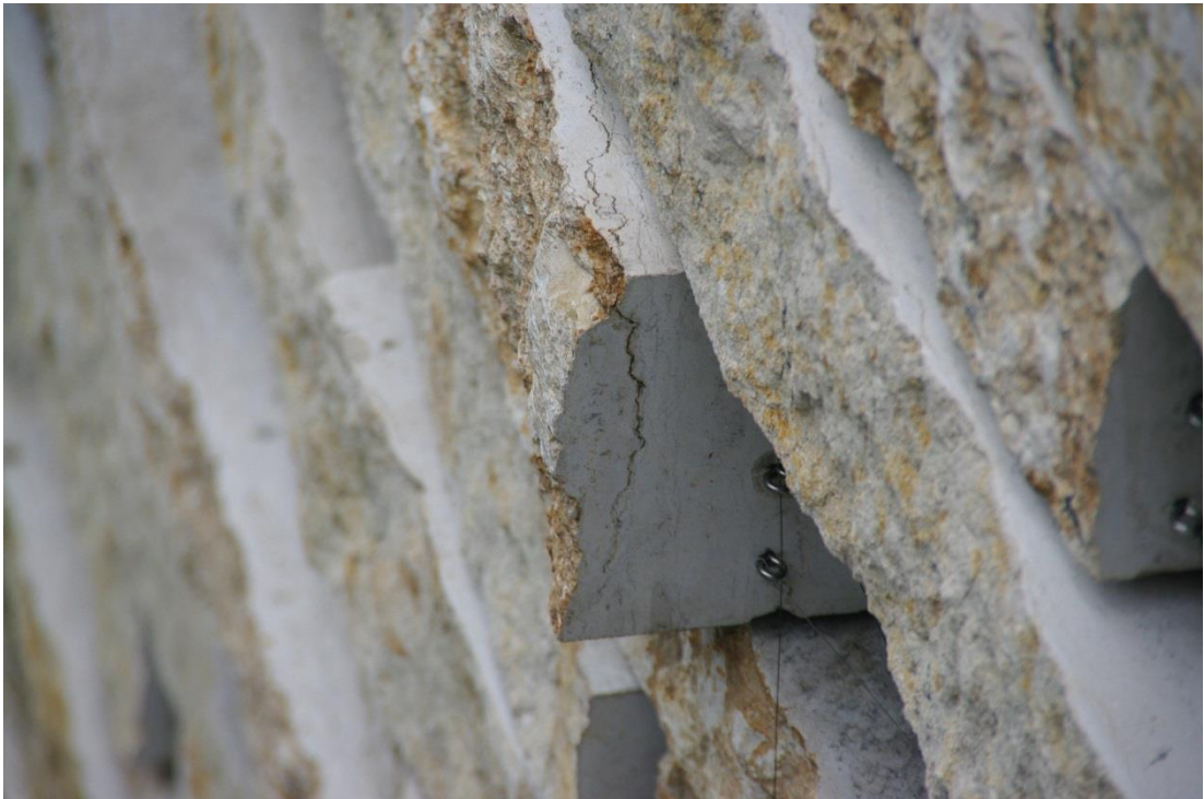
Foto 36: an der Oberfläche erkennbare Stylolithen setzen sich auf der Stirnseite des Mauersteins fort; deutliche Aufweitung im oberen Bereich
