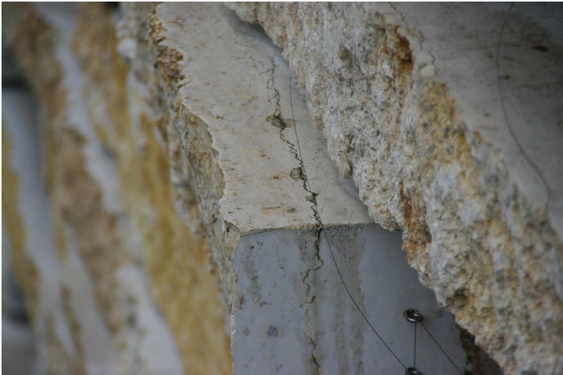
Foto 34: Beispiel für weiter hinten liegende Stylolithen, bei denen sich ggf. dickere Schichtpakete ablösen können
