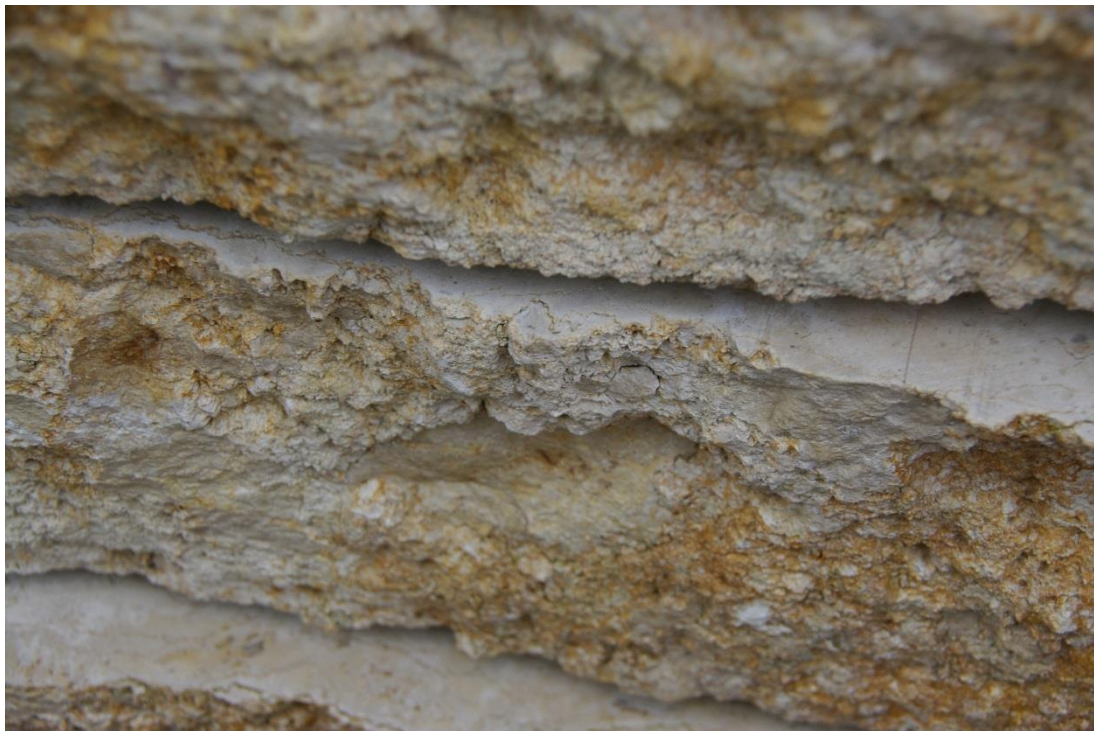
Foto 7: Ablösungserscheinungen resp. Ausbildung von Scherben an der Krustenoberfläche
