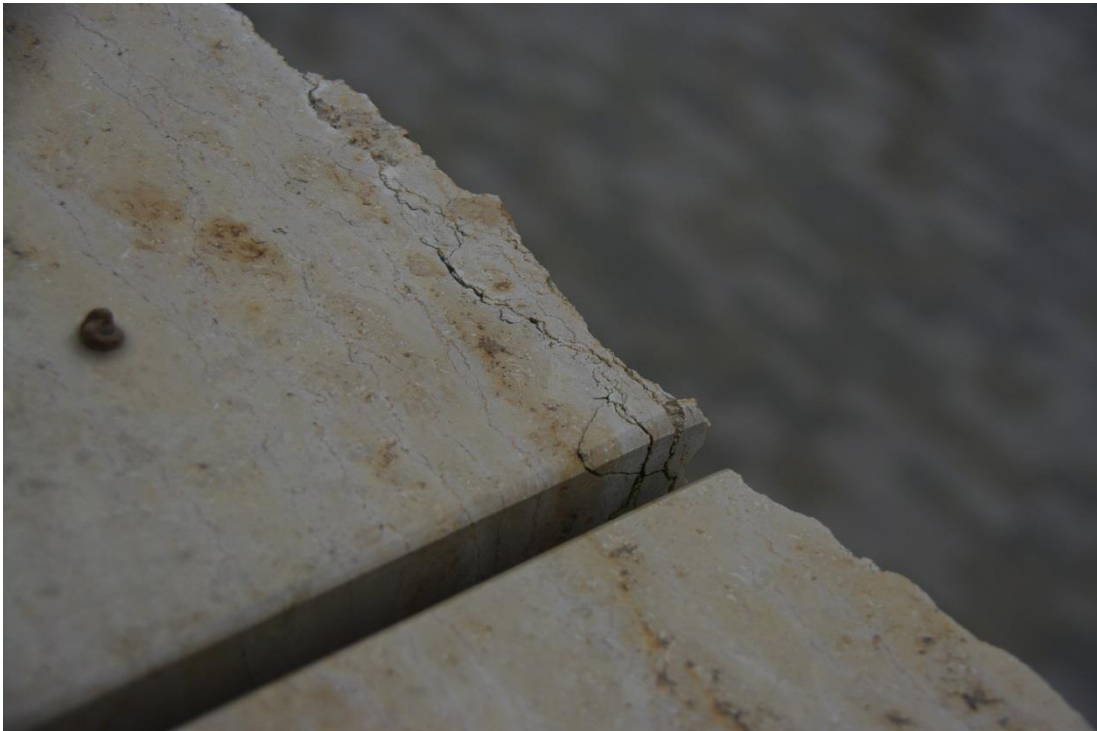
Foto 24: an der Krustenoberfläche „auskeilende“ Stylolithen
