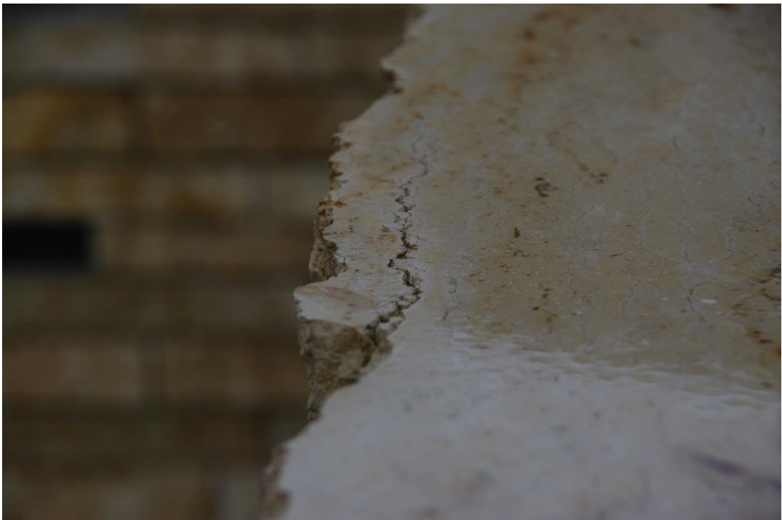
Foto 23: an der Krustenoberfläche „auskeilende“ Stylolithen; Scherbenbildung vorprogrammiert
