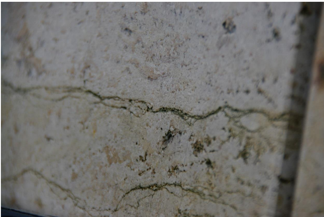
Foto 33: Beispiel für weiter hinten liegende Stylolithen, bei denen sich ggf. dickere Schichtpakete ablösen können
