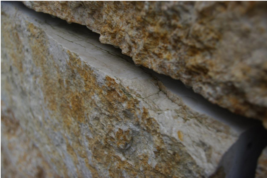
Foto 28: Beispiel für weiter hinten liegende Stylolithen, bei denen sich ggf. dickere Schichtpakete ablösen können
