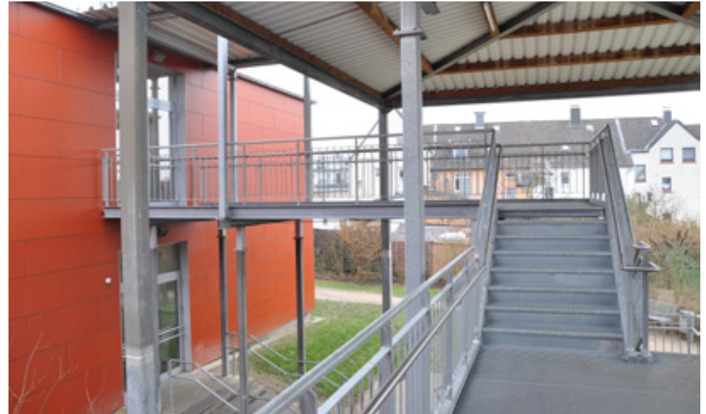
Erschließungsstege im Außenraum
