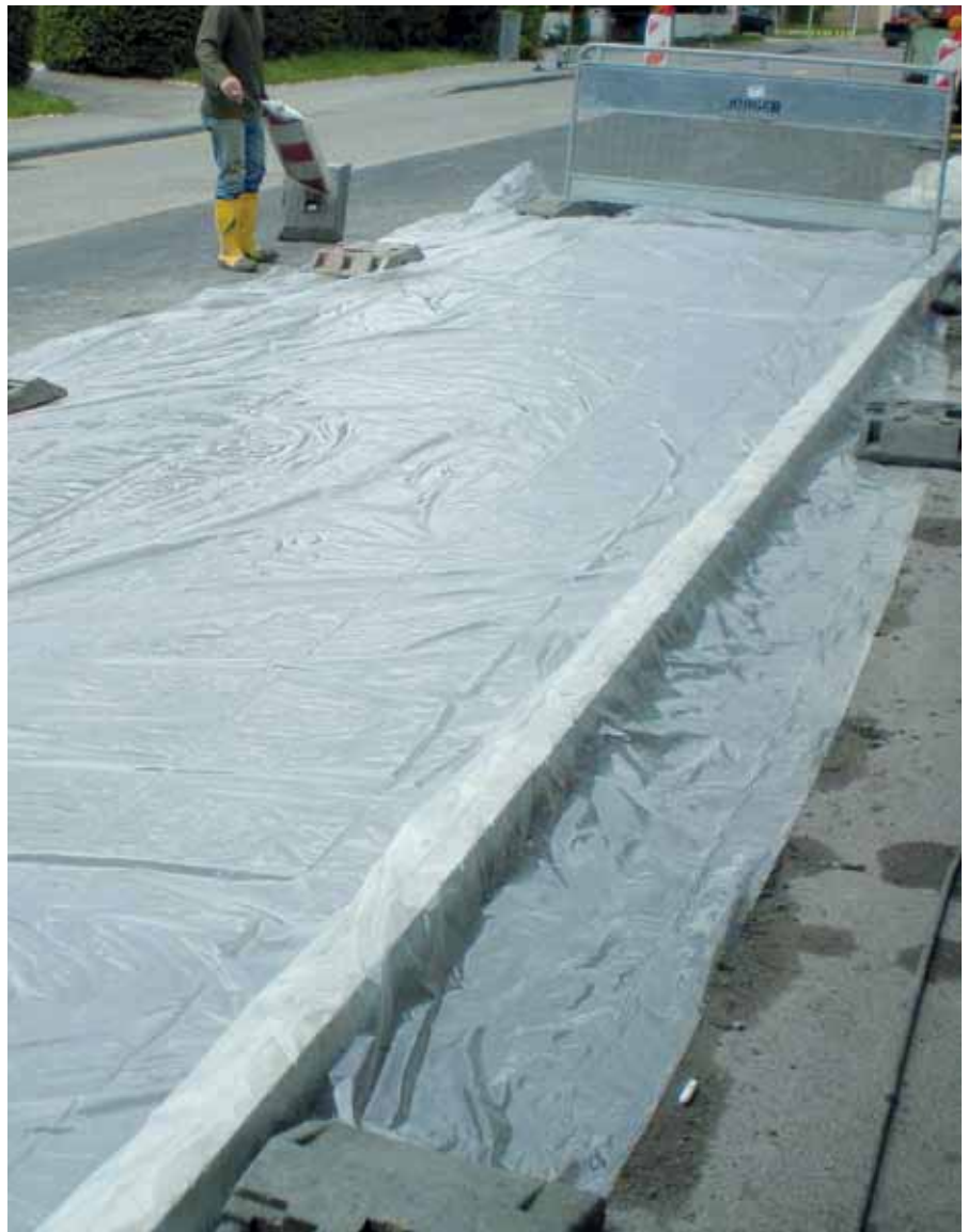
Whitetopping – Einbau und Oberflächenbehandlung sowie Nachbehandlung durch Folienabdeckung (Riffel, 2009)
