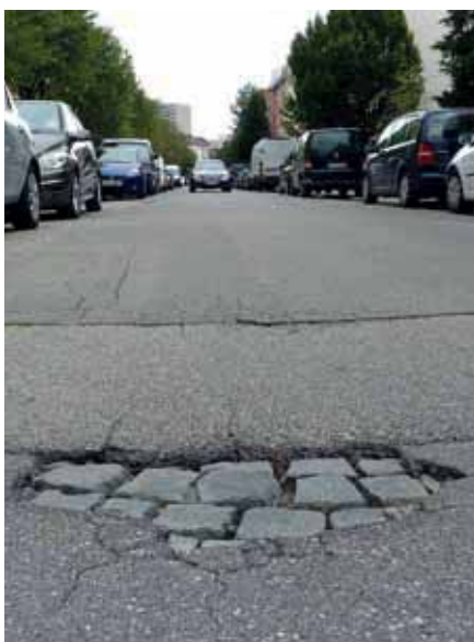
Natursteinpflasterstraße mit dünnem Asphaltbelag (ADAC)
