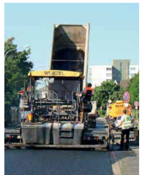
Neueinbau einer Fahrbahndecke (Deutscher Asphaltverband)
