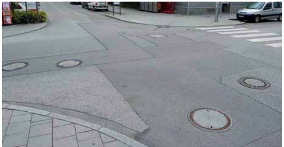
Aufgrabungen der Versorgungsträger (ADAC)
