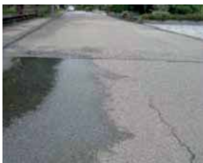
stark ausgeprägte Spurrinnen im Teilabschnitt
