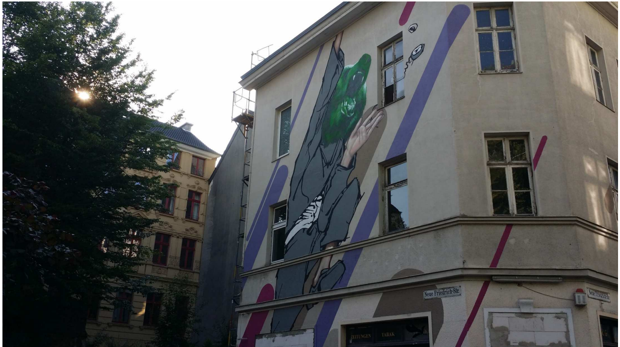
Neue Friedrichstraße 6 (rechts): Problemimmobilie (Die Sanierung stockt seit zwei Jahren), Neue Friedrichstraße 6b (links): sehr gut saniertes Baudenkmal, beide Objekte direkt neben der Kreuz-/Diakoniekirche
