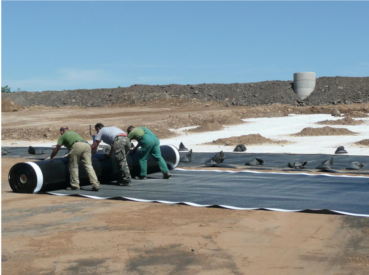
Abdichtungsarbeiten im zentralen Plateaubereich
