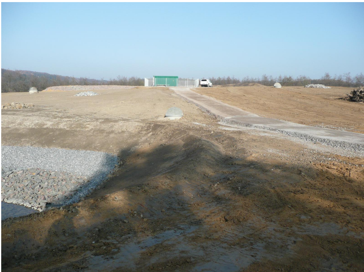
Flächenansicht nach Abschluss der Abdichtungsarbeiten
