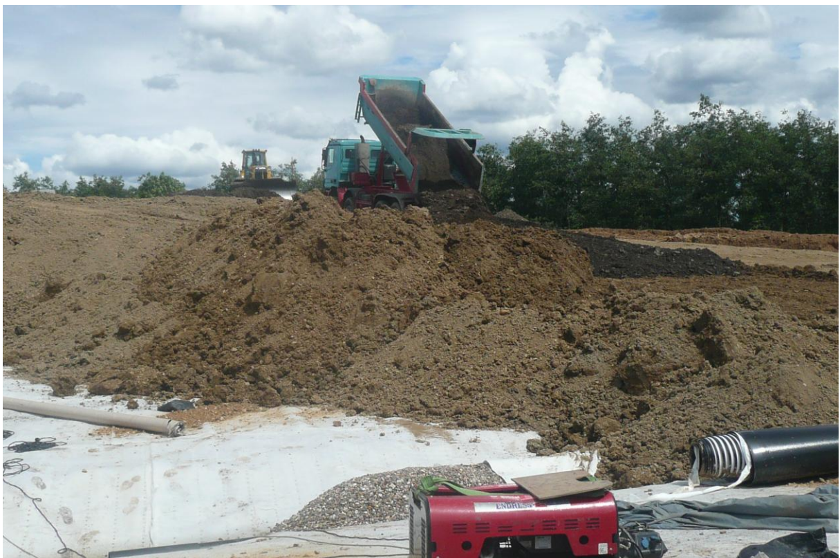
Andeckung mit Rekultivierungsboden
