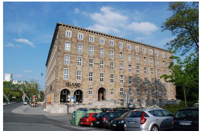
Alexanderstraße 18: Jugendamt und Schulamt in einem Gebäude
