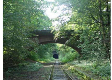
Rheinische Strecke im Bereich des Bahnhofes Ottenbruch, Tunnel Dorp im Hintergrund
