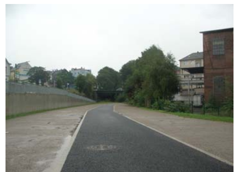
Der Einstiegspunkt „Am Diek“ ist bereits hergestellt
