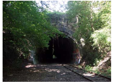
Einschnitte und Tunnel
