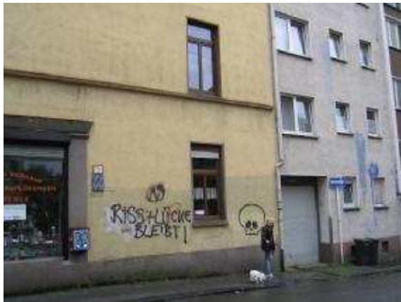
Wülfratherstraße: ungepflegte und verunstaltete Wohnhäuser
