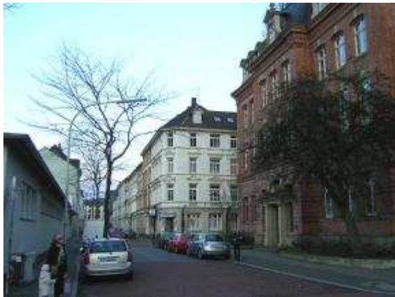
Gutenbergstraße: Beispiel für historischen Gebäudebestand in einfachem Zustand
