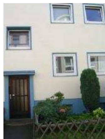
Franzenstraße: saniertes Wohnhaus mit Vorgartengestaltung
