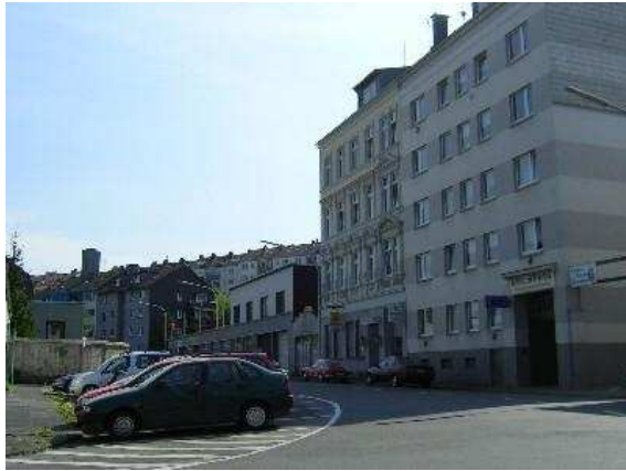
Viethofstraße: Gemengelage von Wohnnutzung und Gewerbe
