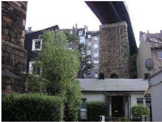
Schwarzbach: Gebäudebestand unterhalb von Brücken
