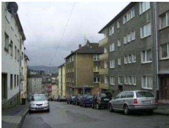
Höchsten: sehr dichte Bebauung, meist in unsaniertem Zustand
