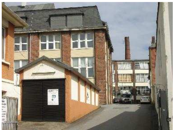
Kreuzstraße: Fabrikgelände im Wohngebiet
