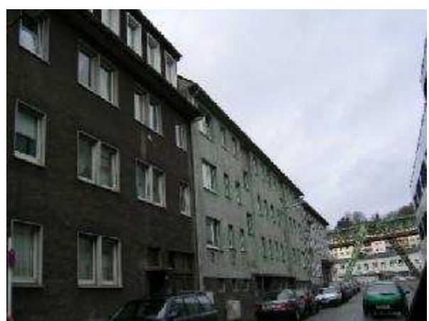
Wasserstraße: unsanierte 50er-Jahre-Zeilbauten
