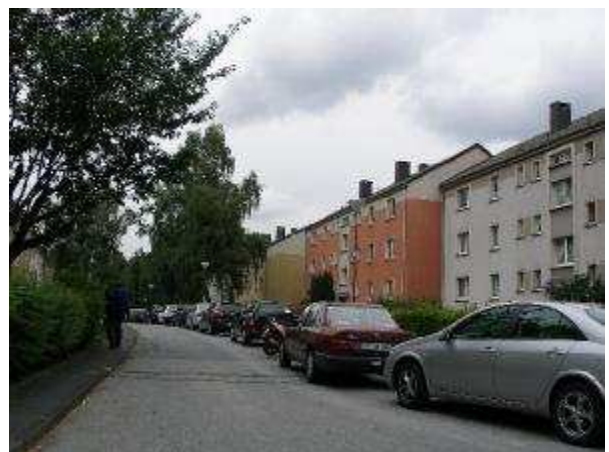
Togostraße: sanierte 50er Jahre Geschosswohnungen
