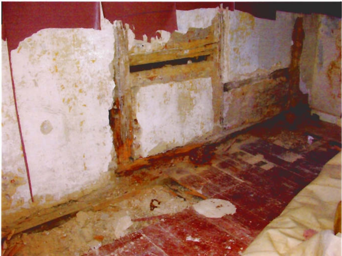
Bild 6: Bauteilfreilegungen an der westlichen Giebelseite des Gebäudes
