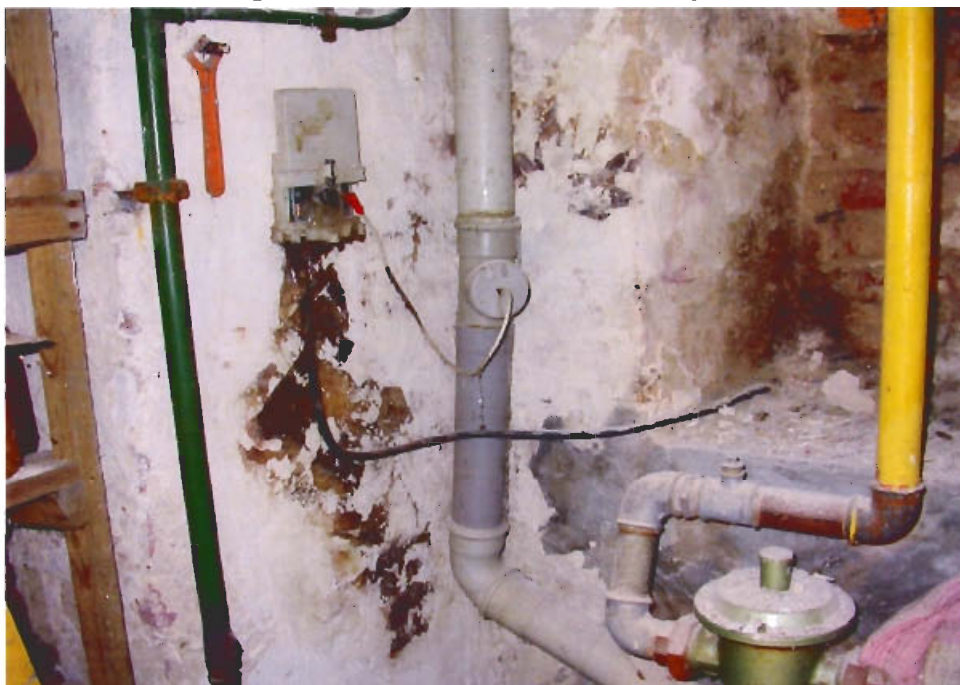
Bild 4: Myzelüberwachungen vom Echten Hausschwamm im straßenseitigen Hausanschlussraum im Kellergeschoss
